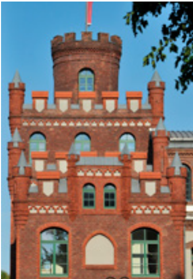
Verwaltungsgebäude der Zeche Adolf von Hanseemann in Dortmund-Mengede.
