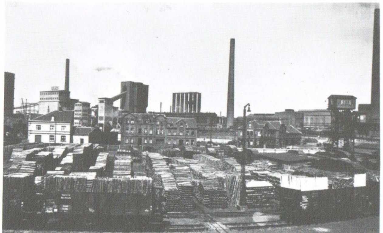
...sie befand sich an der ehemaligen Straße nach Kirchderne, linkes Haus
